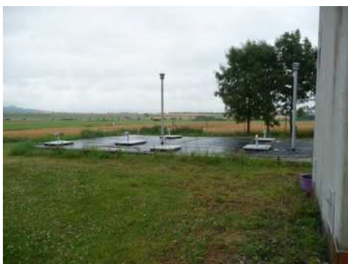
podzemní nádrž na pozemku St. 228
