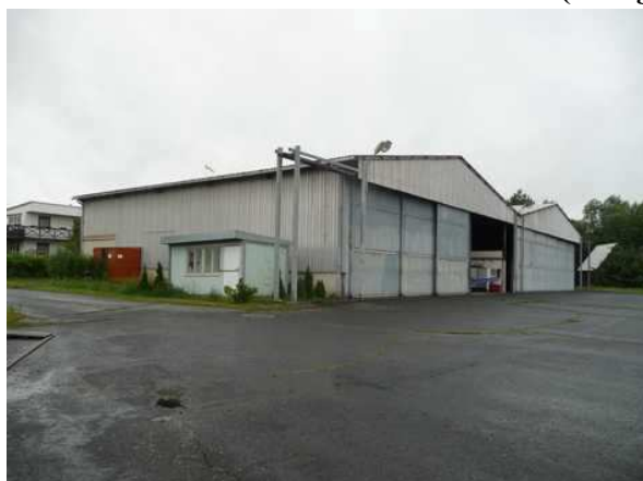
pohled na halu od severu
