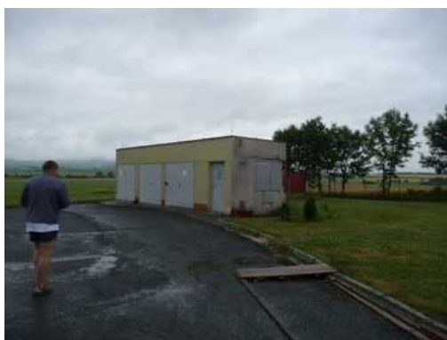
Zděná budova čerpací stanice PH na St. 227
