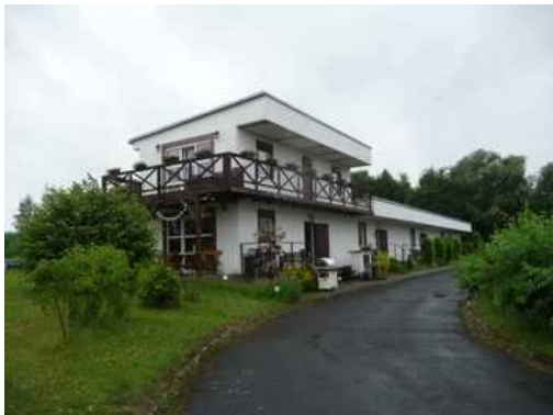
pohled od severovýchodu
