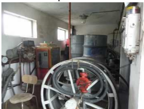
interiér čerpací stanice
